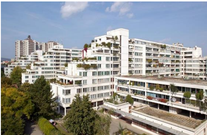
Fig. 29 Social Housing Am Schöpfwerk
